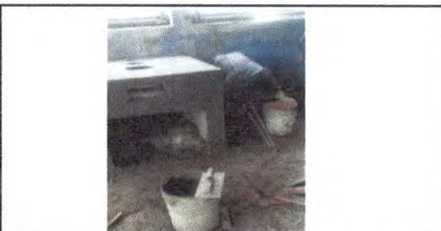
Foto 6: Sustitución de estufa rural incluye chimenea de ladrillo y plancha de metal en módulo 2 cocina
