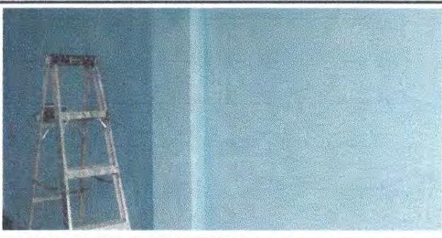
Foto 17: Pintura en murosinteriores del modulo 1
