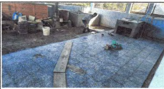
Foto 4: Sustitución de adoquín por piso granito en módulo dos cocina
