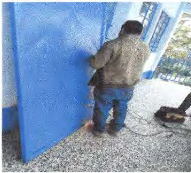
Foto1: Mantenimiento de estructura: Sustitución de Chapa yale en puerta de aula módulo 1
