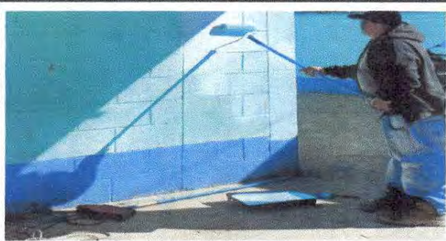
Foto13: Pintura en muros exteriores
