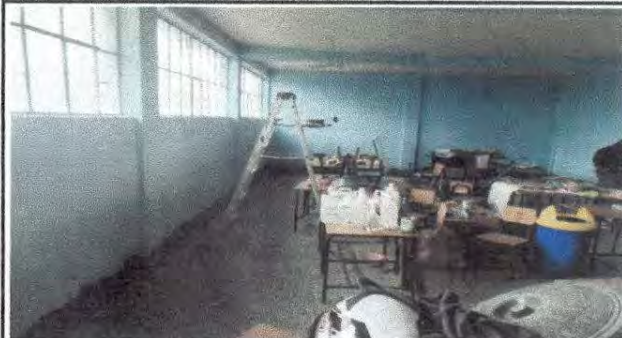
14: Pintura en muros interiores del modulo 1
