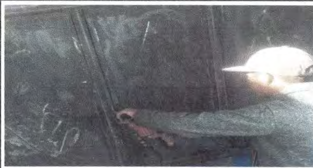
Foto 2: Mantenimiento de estructura: lijado y aplicación de pintura en puerta de metal del módulo 2 cocina
