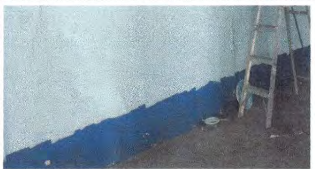
Foto 15: Pintura en muros interiores del modulo 2
